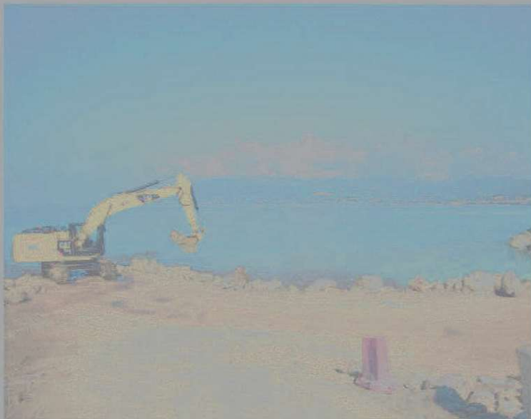
Uno dei cantieri del ripascimento avviato negli scorsi anni
